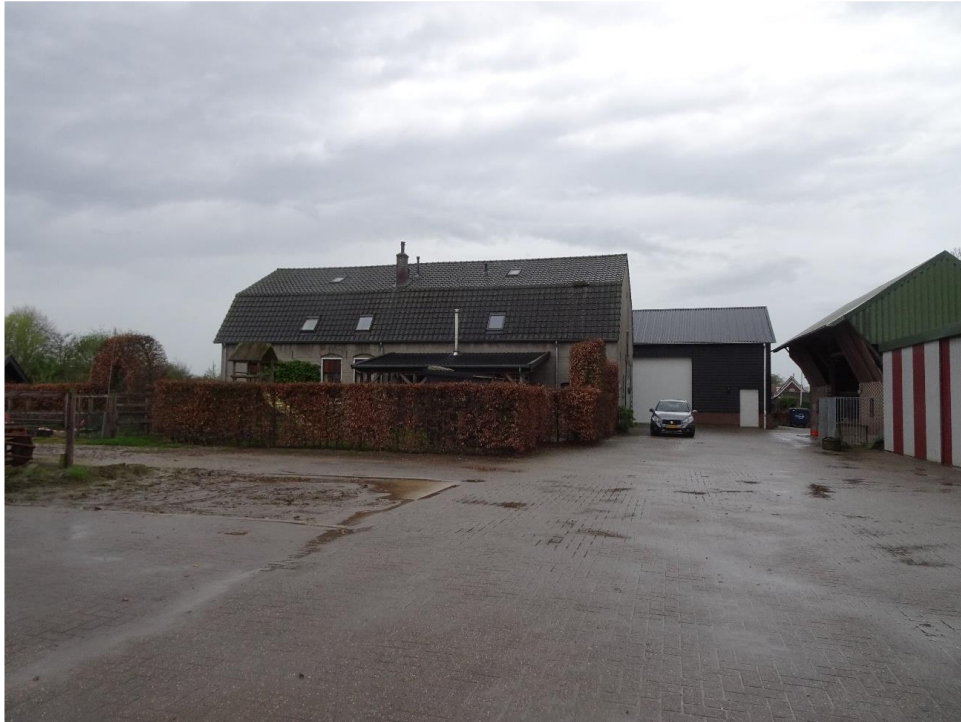
Zicht op de woning vanaf het voorerf
