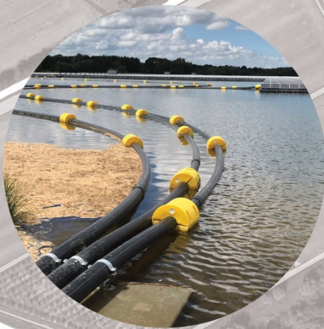
Voorbeeld van aan land brengen van de kabels
