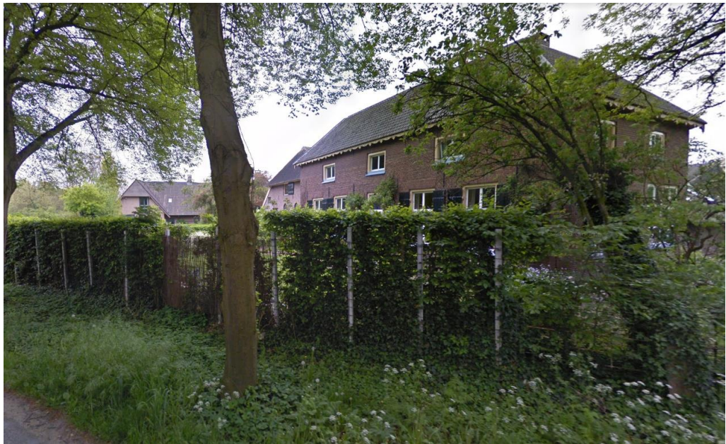
Aanzicht van de woningen vanaf de Westkanaalweg (nummer 4 op de voorgrond, nummer 6 op de achtergrond), april 2019 (bron: google.maps)
