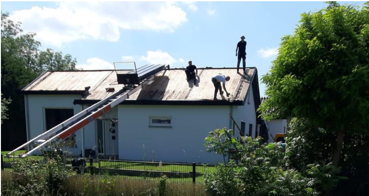
Weergave van de dakrenovatie in 2019. (bron: Opdrachtgever)
