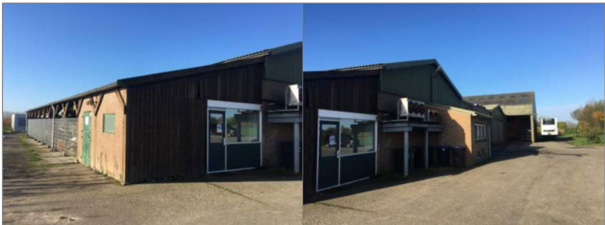
Figuur 2.3: Foto's van de bestaande situatie.
